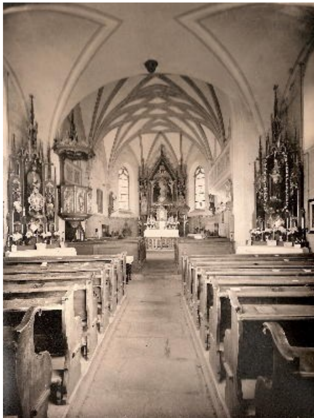
Ил. 24. Интерьер приходской церкви в Кронсторфе
