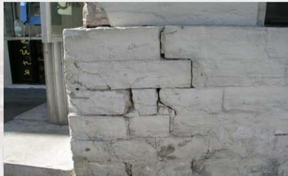
Локальный участок разрушения белокаменной кладки стены в цокольной части, трещины шириной раскрытия до 30 мм в осях 1/А
