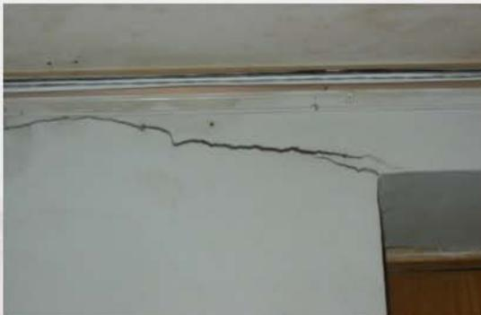
Горизонтальная трещина шириной раскрытия до 4 мм в углу дверного проема перегородки в уровне 1-го этажа в осях 10-12/Л-М
