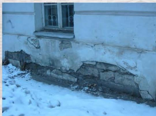
Обрушение штукатурного слоя, выветривание и разрушение белокаменной кладки цокольной части фасада в осях 4-5/К
