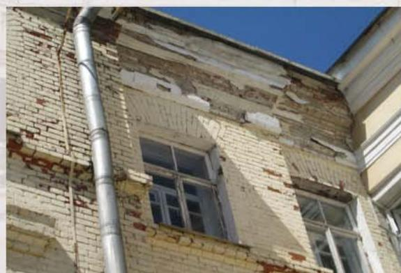
Разрушение штукатурного слоя и выветривание кирпичной кладки в уровне 3-го этажа и карниза на фасаде в осях 7/Н-И
